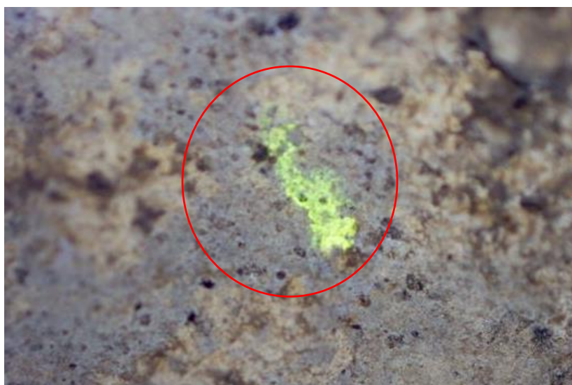
Rückseite einer Epoxy-Beschichtung. Sichtbarmachung des Wasserflusses durch das Pinhole mittels Kontrastmittel.
